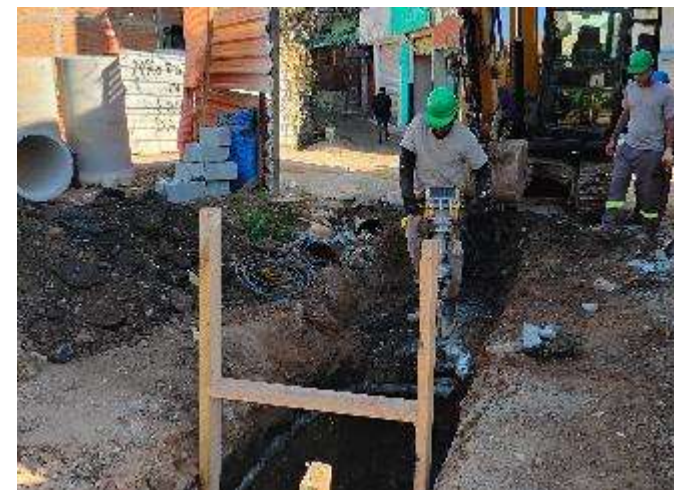
Fase 4 – Execução de drenagem nas vias
