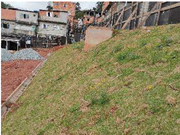
Trecho 2 – Execução de talude e drenagem
