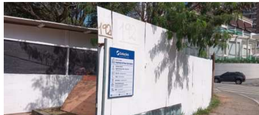
Canteiro de obras Local: Praça Sede Realizado em junho/2026
