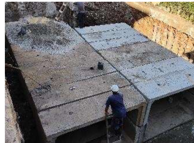
Fase 2 – Execução tanque de retenção
