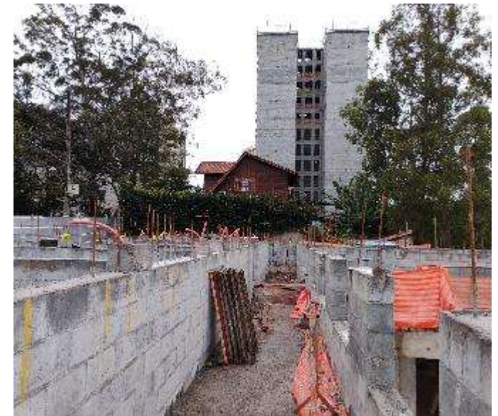
E2 – Alvenaria 1º pavimento
