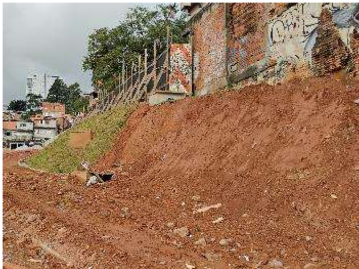
Trecho 1 – Execução de talude
