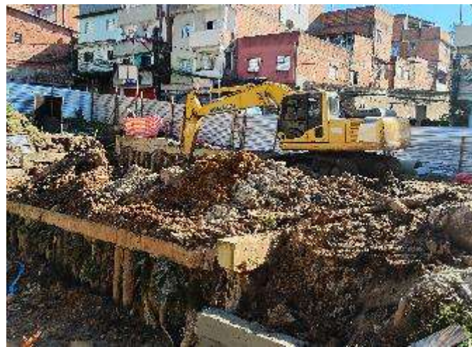
Fase 2 – Execução tanque de retenção
