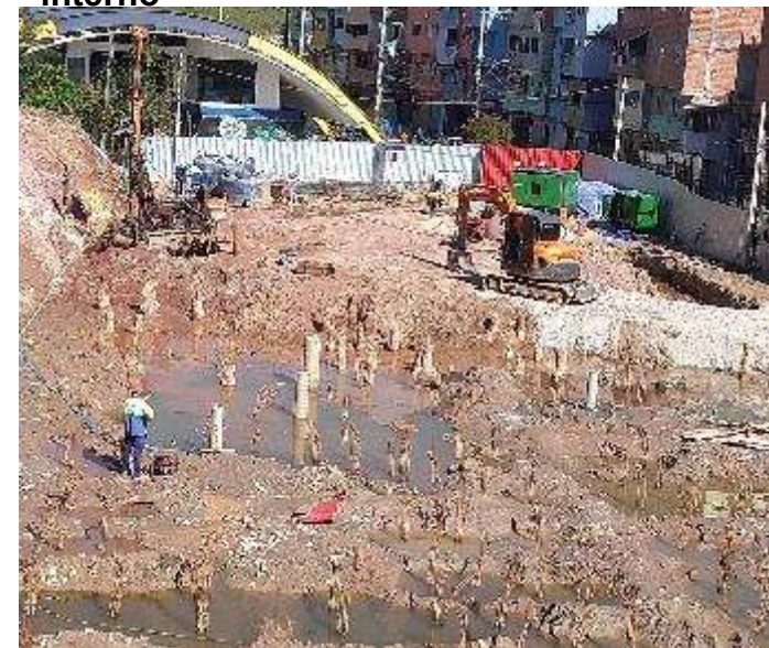
Cond. J – Execução de estacas
