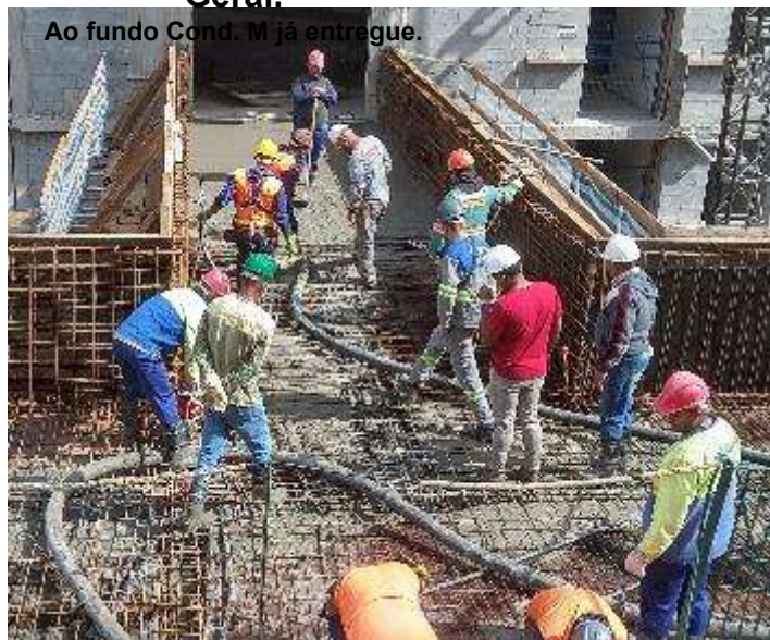
Cond. L – Concretagem passarela de
