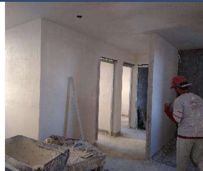
Cond. L – Aplicação de revestimento interno
