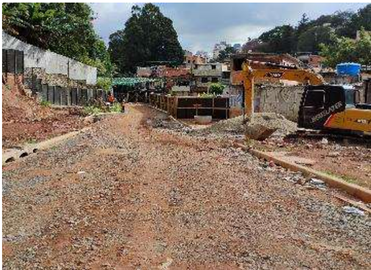
Trecho 1 – Execução de Rua projetada
