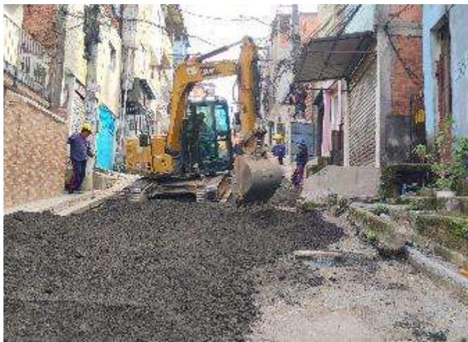
Fase 2 – Pavimentação das vias
