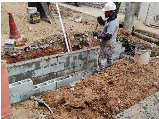
Fase 3 – Execução de drenagem nas vias
