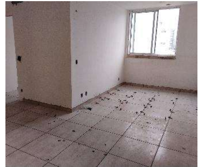
E1A – Execução de pisos
