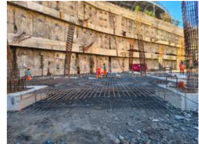
Reservatório RA02 - Área 8 Armadura da laje de fundo
