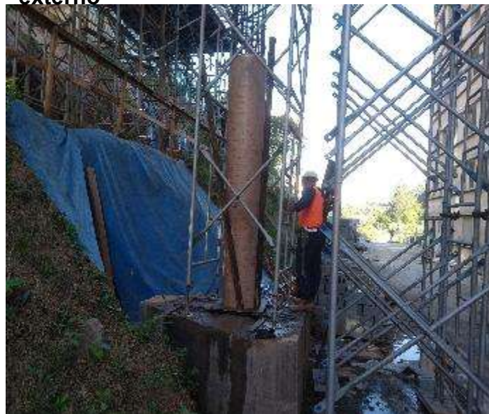
Cond. L – Concretagem coluna da passarela de
