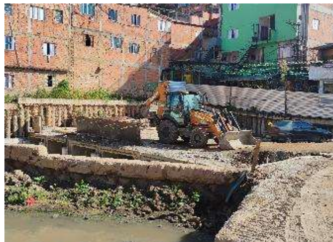
Fase 4 – Execução tanque de retenção
