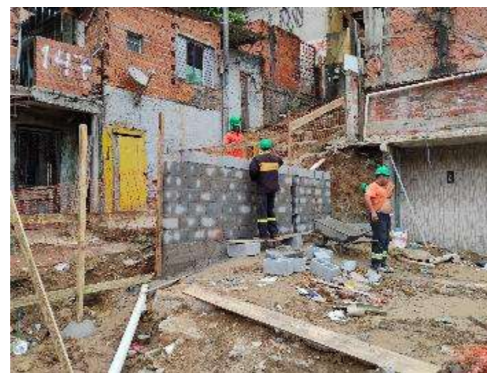
Trecho 3 - Readequação de muro
