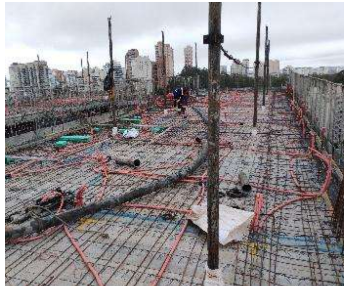
E1B – Execução laje 14º andar
