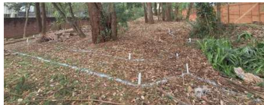
Locação de obras Local: Praça Porto Seguro Iniciado em julho/2026
