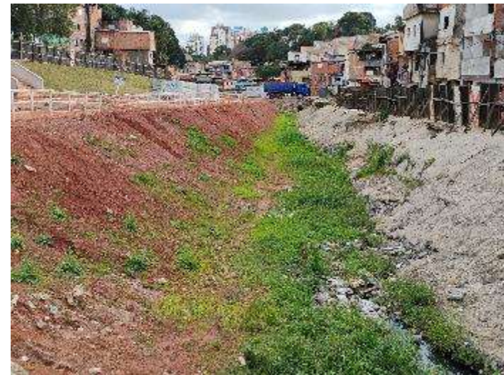
Trecho 2 – Canalização e estabilização das moradias
