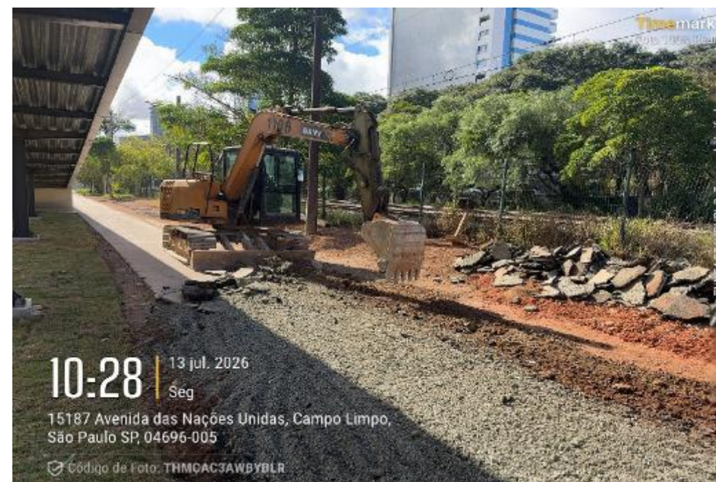
Remoção do revestimento asfáltico existente na ciclofaixa – EMAE – Rampa cicloviária.
