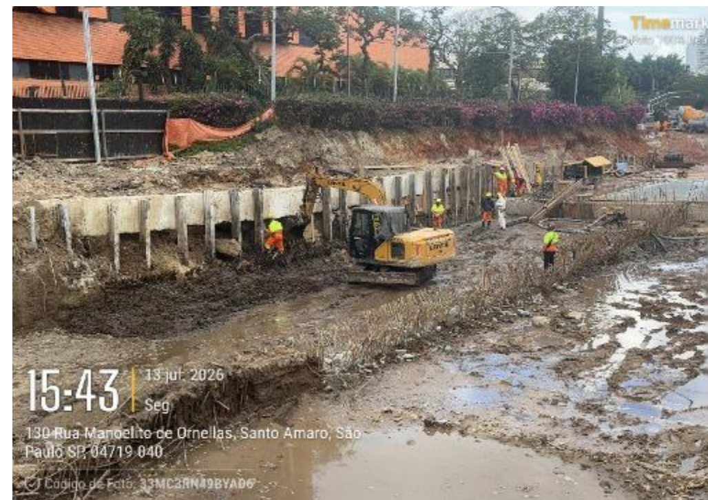
Escavação para execução da laje superior – Entre as estacas 33 e 34.
