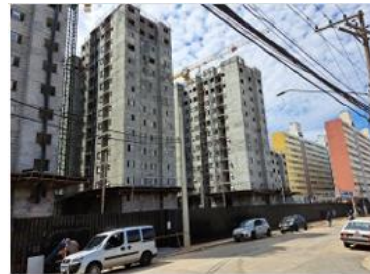
Foto 02 - Vista externa - Torres 01, 02, 03 e 04 (frente) Campo Belo "AB" - Implantação (R. Estevão Baião)
