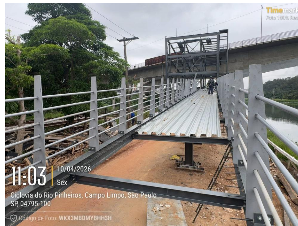
EMAE - CICLOVIA - RAMPA - Instalação do guarda-corpo da rampa de acesso
