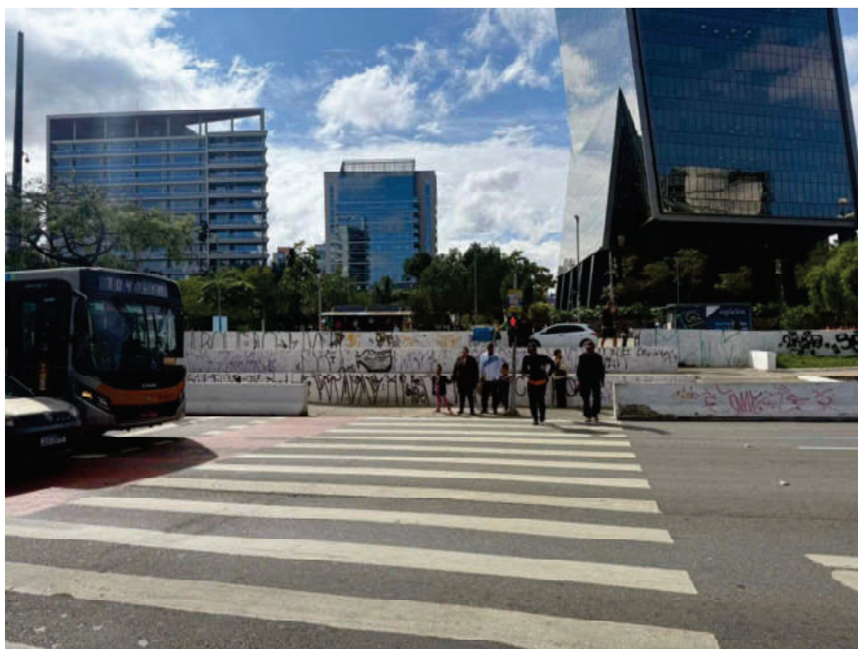
Figura 01 – Trecho de desnível entre os dois lados da Av. Faria Lima.
