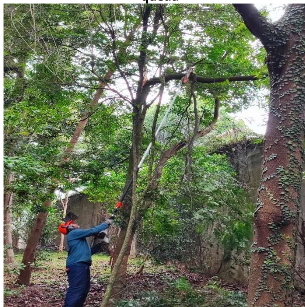
Figura 64 poda de galho quebrado com risco de queda
