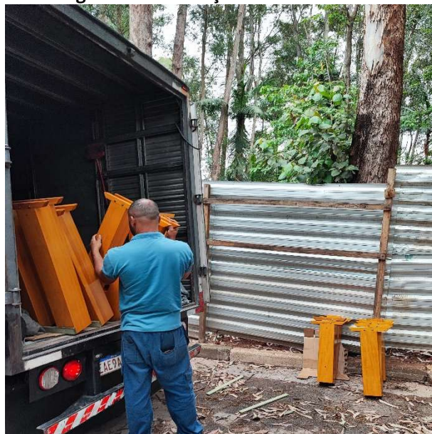
Figura 138 instalação de mesas novas
