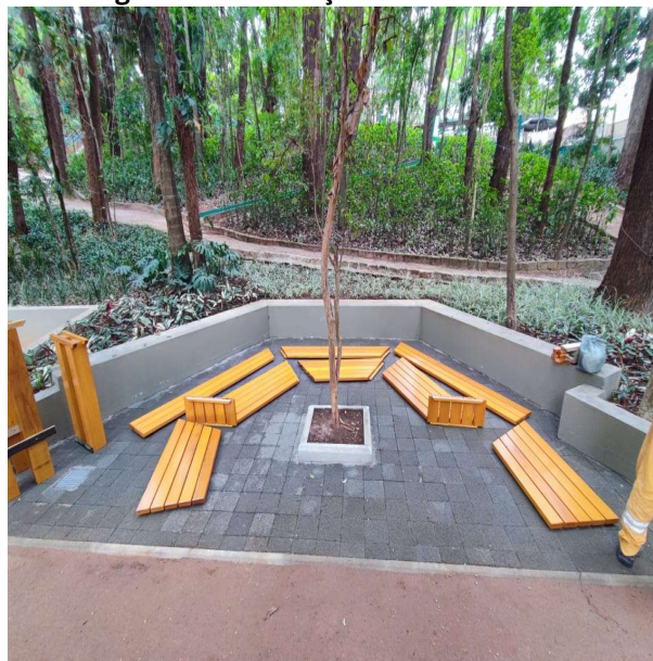
Figura 139 instalação de mesas novas
