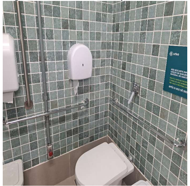
Figura 167 troca de barras de apoio do vestiário
