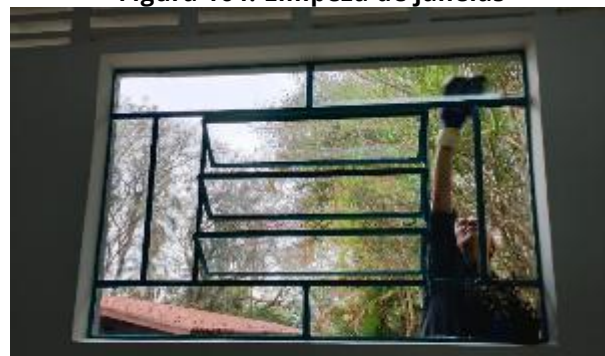
Figura 164: Limpeza de janelas
